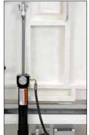
Mecanismo de cierre automático Cierra la puerta automáticamente en caso de incendio. La puerta permanece firmemente cerrada para evitar la propagación del fuego entre los pisos del edificio.
